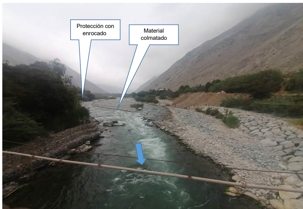
FIGURA N°02: TRAMO CRÍTICO, AGUAS ARRIBA DEL PUENTE CATAPALLA, MATERIAL COLMATADO
